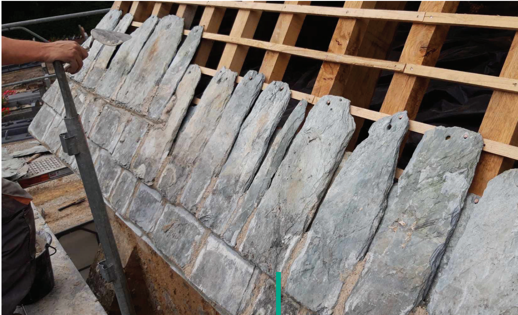
MISE EN OEUVRE D'UNE COUVERTURE EN PIERRE DE PAYS
